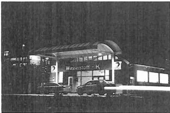
Wasserstofftankstelle Holzmarktstraße, Berlin
